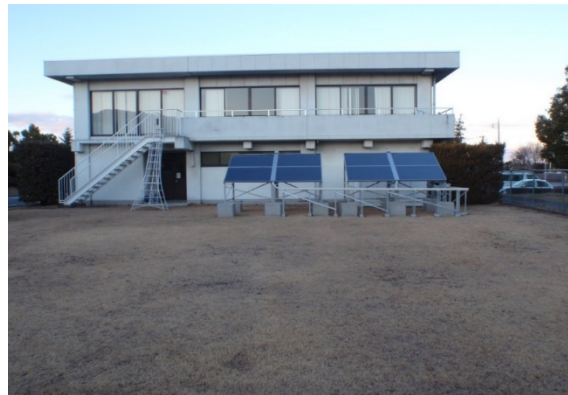
■群馬県 自動車部品製造工場[従業員施設]
